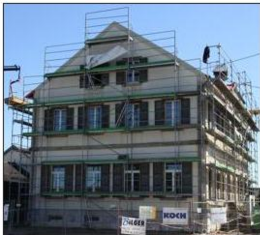
Après les travaux achevés au printemps dernier, le bâtiment qui abritait la mairie-école a été transformé en mairie fonctionnelle, au rez-de-chaussée, et en appartements, à l'étage. Photos « L'Alsace »
