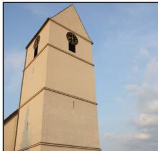
L'église Saint-Blaise et Saint-Léger, située au centre du bourg, est construite contre une tour datant du XIII e siècle.
